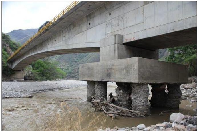
Figura 1.- Socavación en pilas de puente
